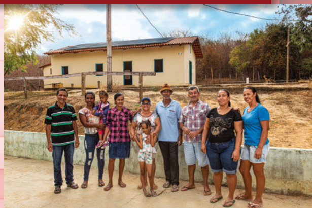
Equipamento de energia solar para comunidades.
