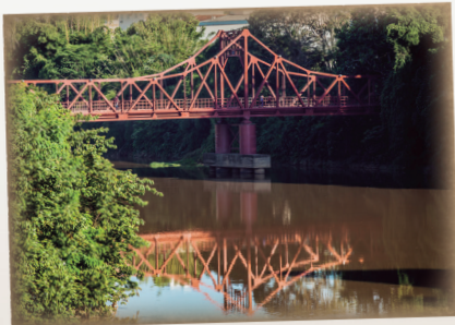
Ponte Astolfo Dutra Nicácio - Ponte Metálica
